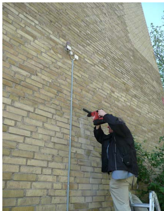
Bild 3.16. Mekaniskt ingrepp i gavel från bild 3.15. Notera nya teglet i bildens högra överdel.
