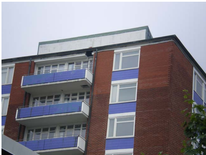
3.8. Åtgärdad fasad vid Parentesen i Lund.
