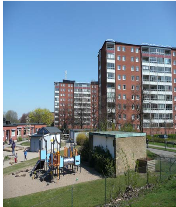
Den närmsta gaveln är den som är åtgärdad.
