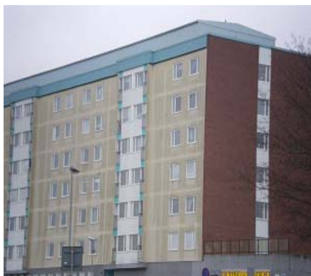
Bild 1.5. Återuppbyggd gavel på Ektorpsgatan, Norrköping.
