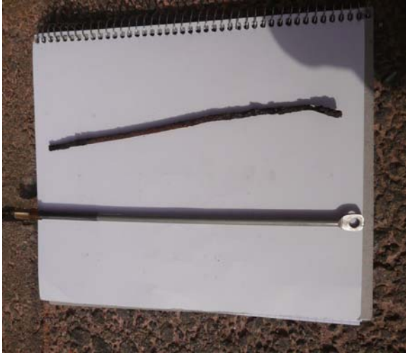
Rostig kramla från österfasad bredvid en ny.
