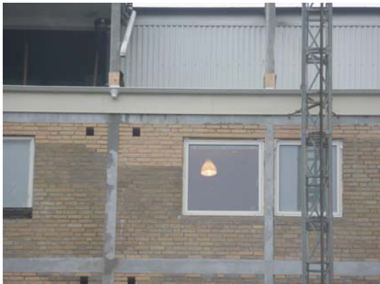
Tilläggskramling och reparationer i samband med fönsterbyte
