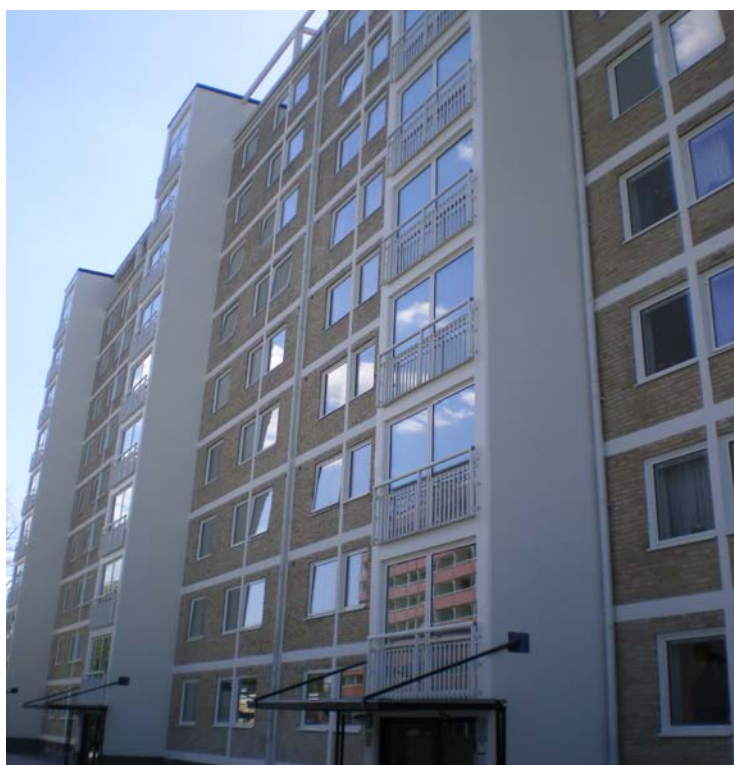
Bild 3.3. Åtgärdad fasad på Karhögstorg, Lund.
