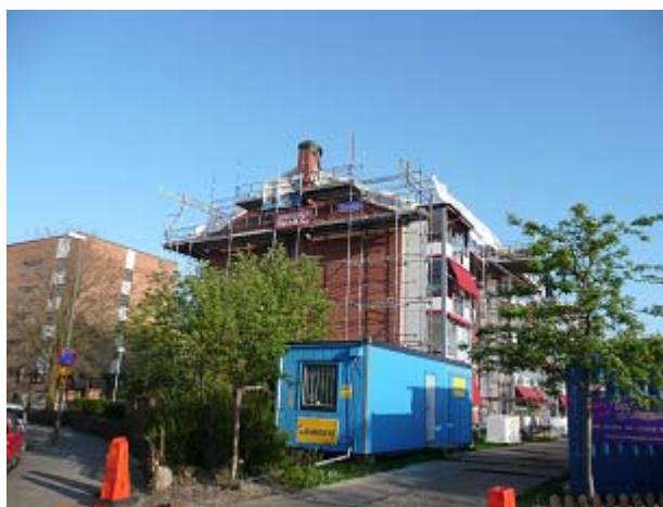
Bild 3.12. Renoveringsobjekt Limhamn, Malmö.
