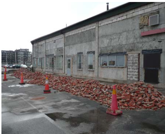
Byte av befintlig skalmur.
