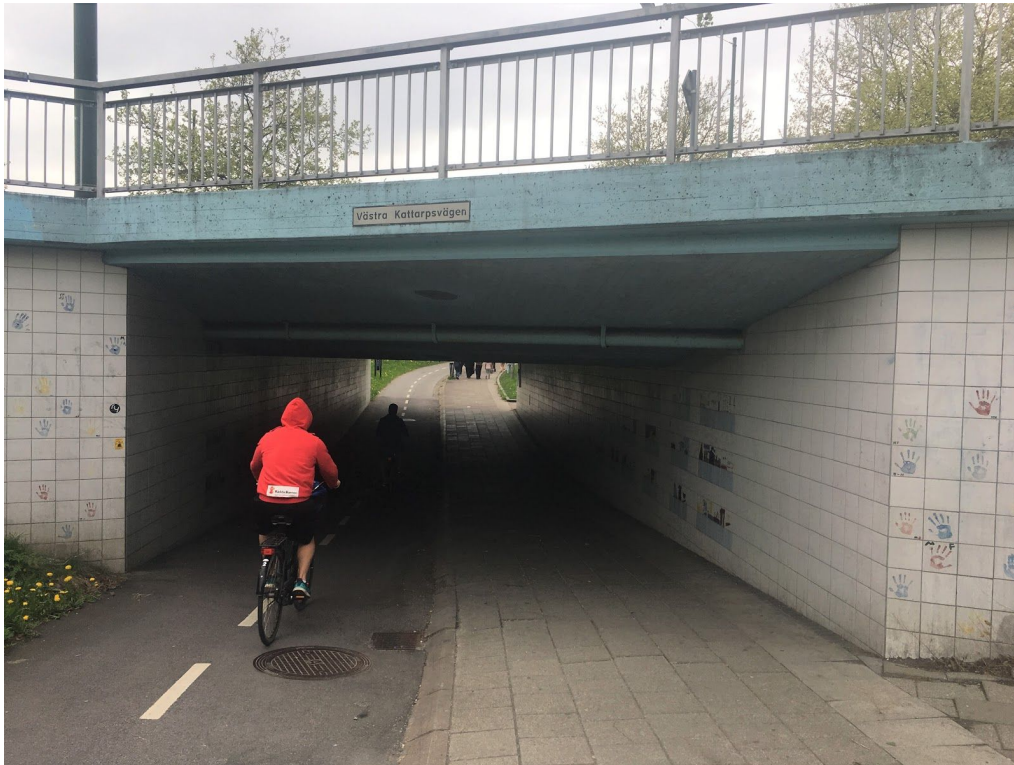
Figure 2. Photo of the tunnel under Västra Kallarpsvägen
