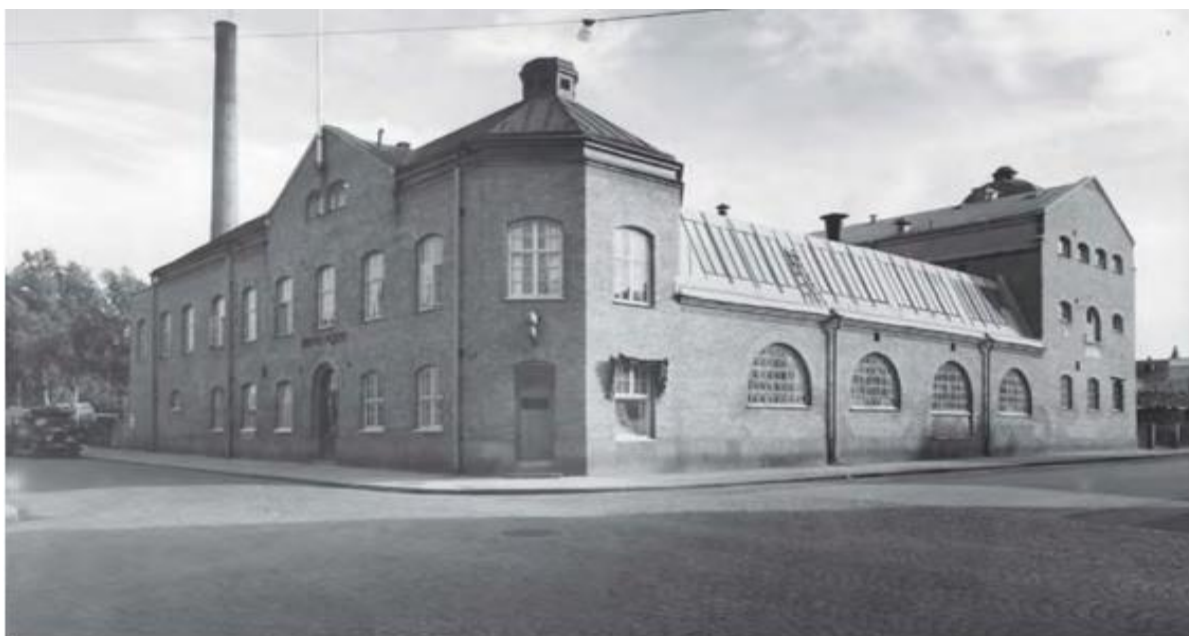
Figur 8 Den stora mejeribyggningen (Isacson & Nisser, 2007)
