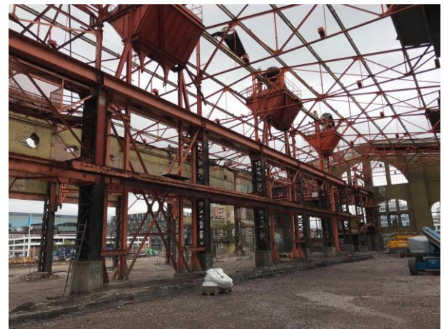
Gjuteriets stora hall.
