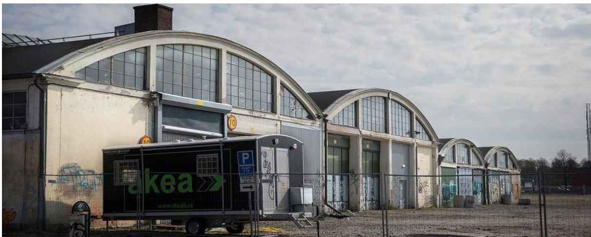
Figur 4 Båghallarna innan ombyggnad (Gillberg, 2015)
