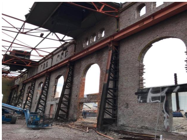
Insidan av Gjuteriets östra del under rivningsarbetet
