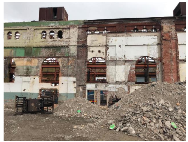
Gjuteriets östra fasad efter rivning av tillbyggnaden.
