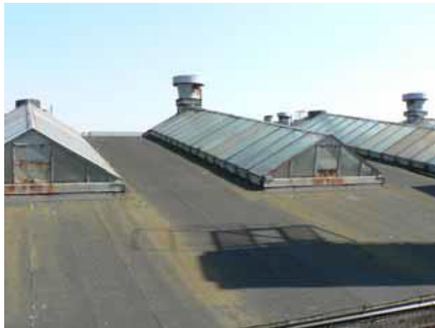
Lanterniner på gjuteriets tak
