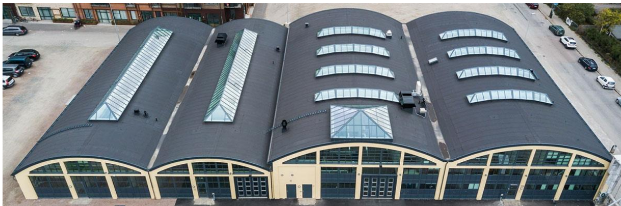
Figur 5 Båghallarna efter ombyggnad (Byggfaktadocu, 2020)
