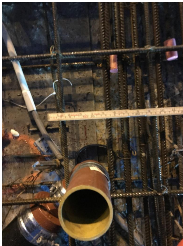
Figur 14 - Avluftning utanför väggen
