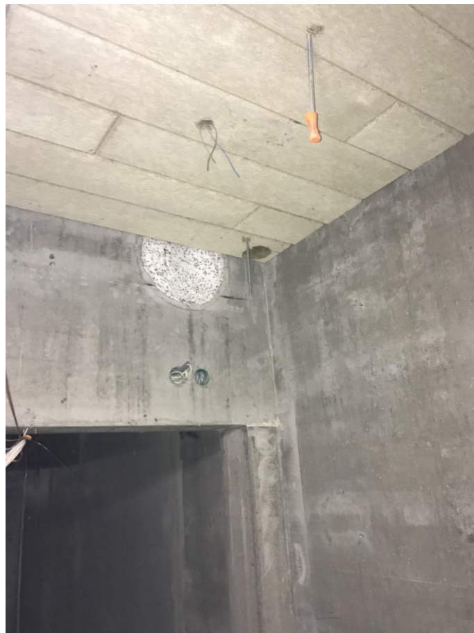
Figur 17 - Genomföring som är felplacerad
