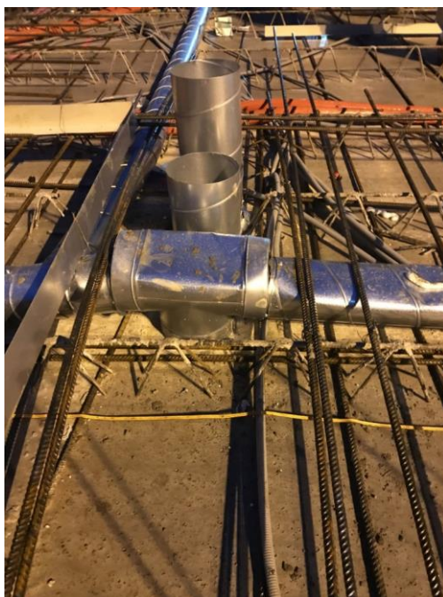
Figur 12 - Ventilationskanal i bjälklag
