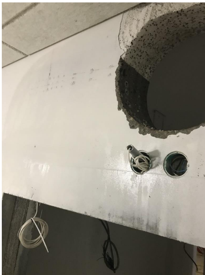
Figur 18 - Genomföring efter håltagning
