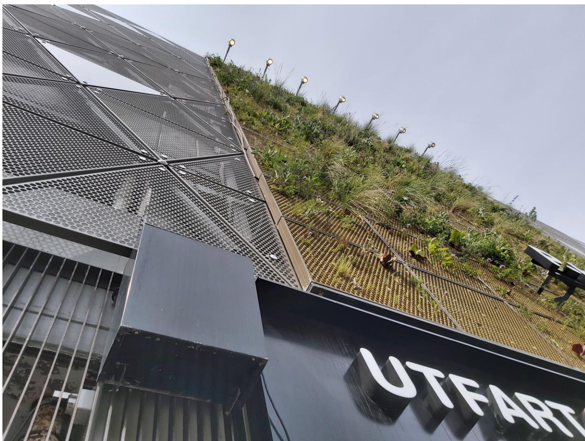
Bild 5. P-huset Anna, bevattning på södra fasaden.
