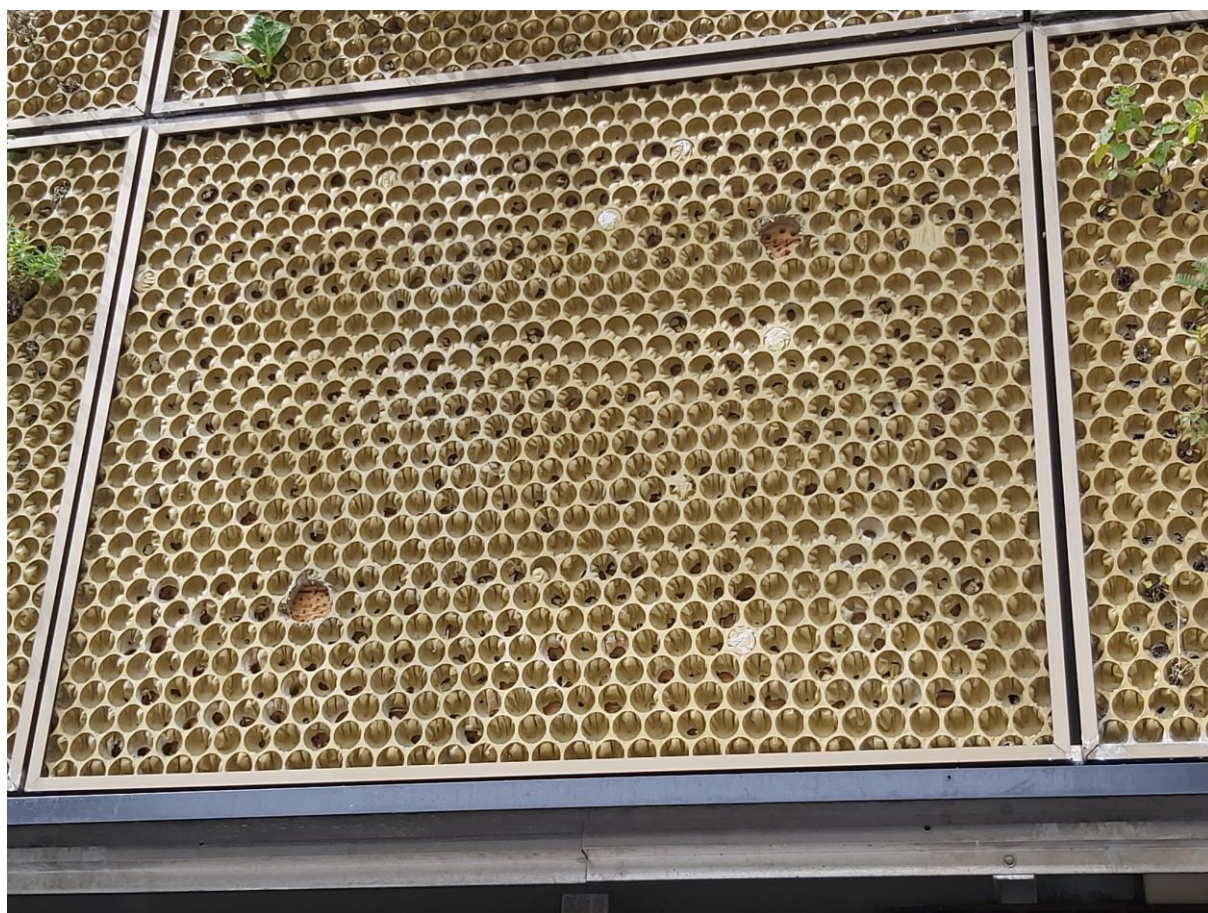
Bild 2. P-huset Anna, insektshotell på södra fasaden.
