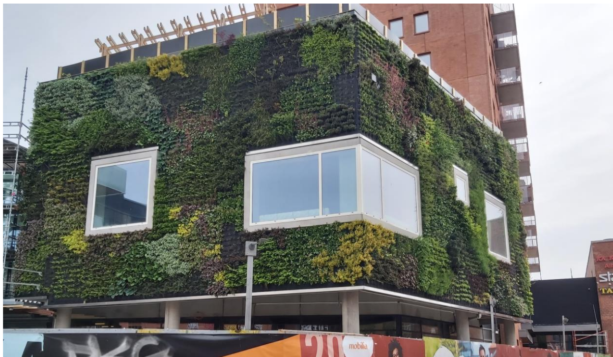
Bild 14. Torghuset, västra och norra fasaden.
