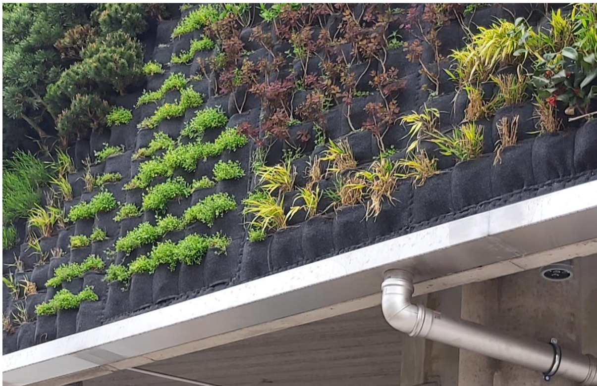
Bild 16. Torghuset, växtfickor och avrinningsystem.
