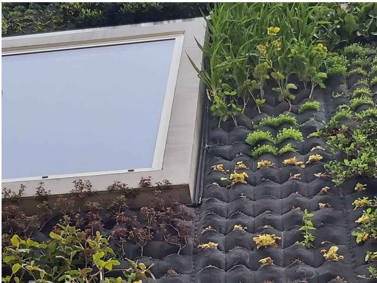
Bild 15. Torghuset, utskjutna fönster från fasadliv.
