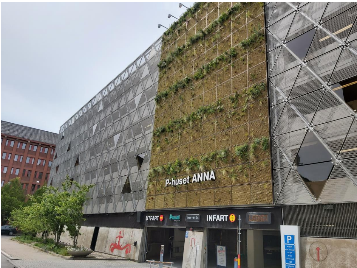
Bild 1. P-huset Anna, södra fasaden.
